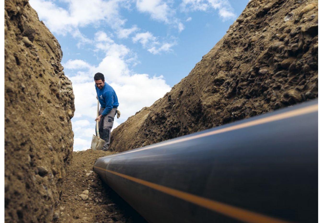
Verlegung einer Gasleitung.
